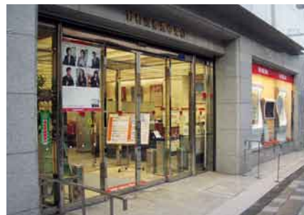
豊中支店 段差を解消した出入口
