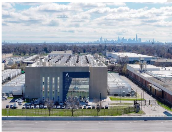
シカゴのAligned Energyデータセンター (Aligned)
