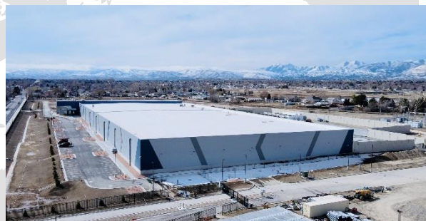
ソルトレイクシティのAligned Energyデータセンター (Aligned)
