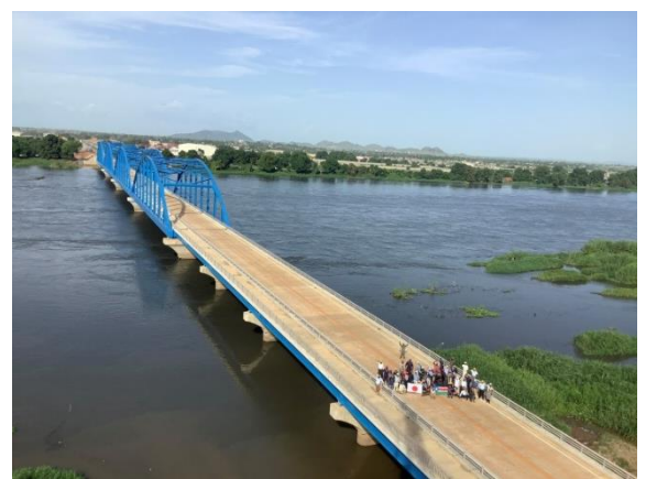
南スーダンで完成した自由の橋（フリーダム・ブリッジ）
