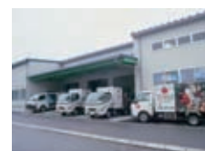
個人向け宅配事業の配送センター
